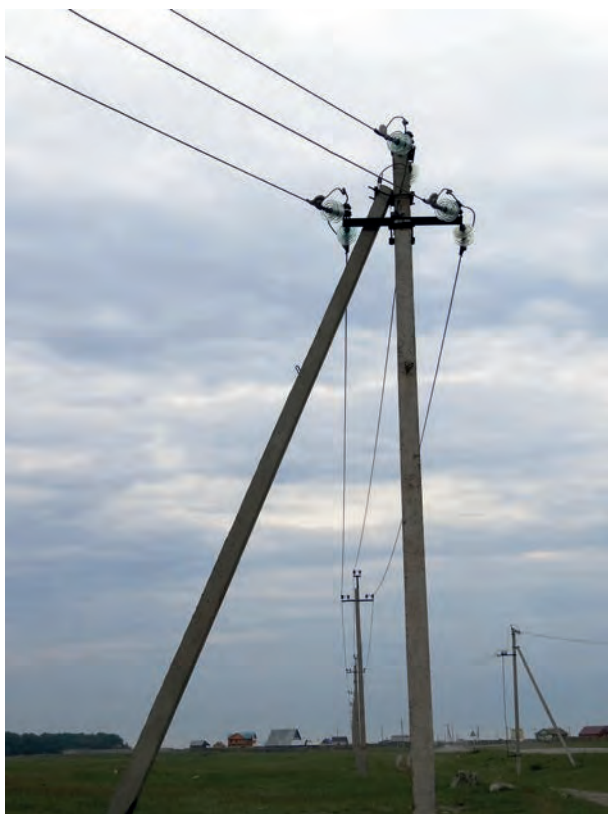
Рис. 1. Угловая опора ЛЭП 10 кВ.
