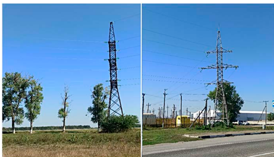
Рис. 2. Расположение опор ЛЭП относительно автодороги и нефтяного предприятия
